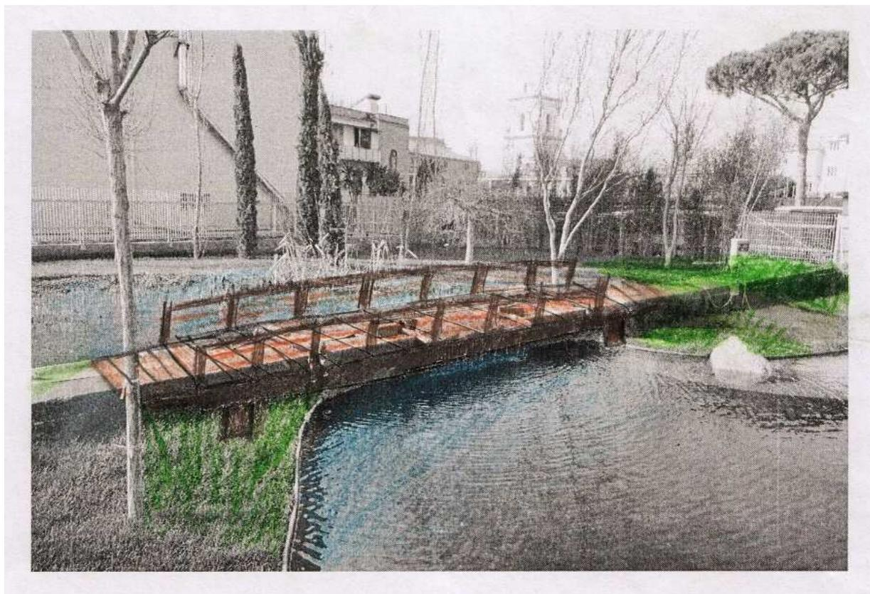
Ponte di tipologica indicativa come da "Figura A"; ml. 7 con due rampe terminali di raccordo al viale da circa ml. 1.50 / cad. – Larghezza piano calpestabile ml. 1.10 – Ringhiera dimensionata e realizzata secondo lo schizzo indicativo "Figura C" , opportunamente dimensionata secondo le indicazione "Figura B".-
